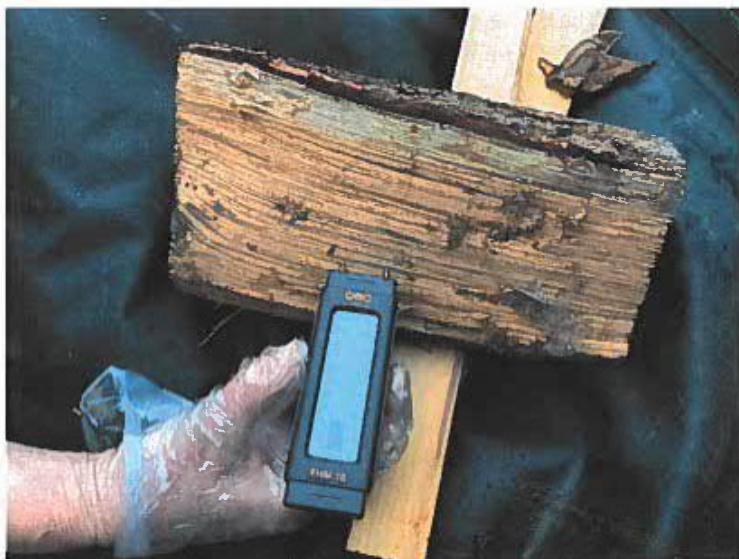
Foto 7: Hout opslagunit, links liggend in de voortuin: Inhoud gekloofd eikenhout ter opslag en droging. Meting vochtigheidspercentage van het aangetroffen eikenhout 15% (gemeten bij een buitentemperatuur van ca. 4 graden).
